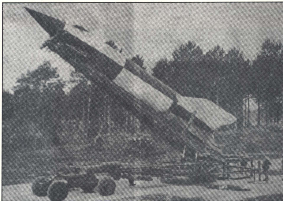
V-2-bombe gøres klar til affyring. Med sin transportable platform og beskedne ydre mål — i forhold til V-1 — var affyringsstationerne næsten umulige at få ram på for allierede bombere. V-2 var 14 meter lang, vejede 13 tons, hvoraf de ni var brændstof. Største fart 5000 km/t. — stigeevne indtil 150—200 kilometer. Praktisk rækkevidde 350 km.
